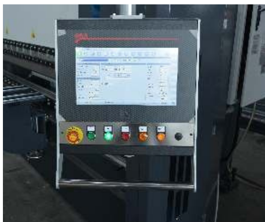
Unità di controllo ESA S 640
